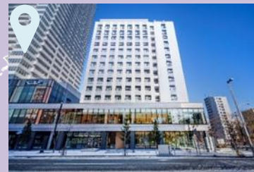
北8西1地区第一種市街地再開発事業 (ホテル棟) (北海道札幌市)
