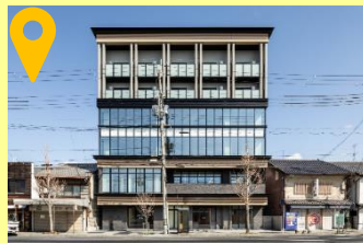
金融機関様 支店建替工事 （店舗・賃貸住宅※シェアキッチン・シェアオフィス付） （京都府京都市）
