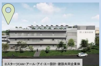
三浦市市民交流拠点整備事業 (三浦市市庁舎、庁舎付属棟、神奈川県保健センター) 2026年11月竣工予定 (神奈川県三浦市)
